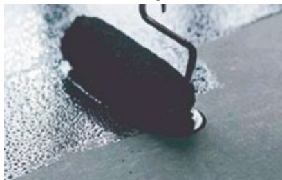
Рисунок 12 – Нанесение праймера на основание.
