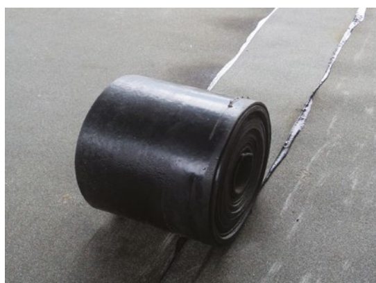
Рисунок 10 – Наплавление Бандажной ленты ICOPAL® .
