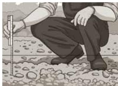
При подготовке несущего слоя осуществляется разметка участка. В ходе разметки участка определяются высоты, углы, направление уклона для дренажа. Для фиксации разметки натягиваются нити.
