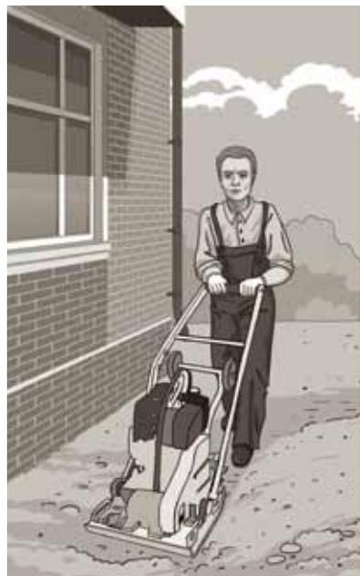
Качественное выполнение работ по подготовке основания на больших площадях может быть обеспечено при использовании автотракторной техники: бульдозер, грейдер, каток и пр.. Участки площадью до 100-150 кв.м, а также участки сложной формы, удобнее подготавливать с помощью специального электро- и бензоинструмента (виброплита, виброрейка и пр.)
