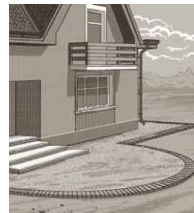
Вид бордюра с уплотненным несущим слоем. Поверхность подготовлена к устройству монтажного слоя и мощению.
