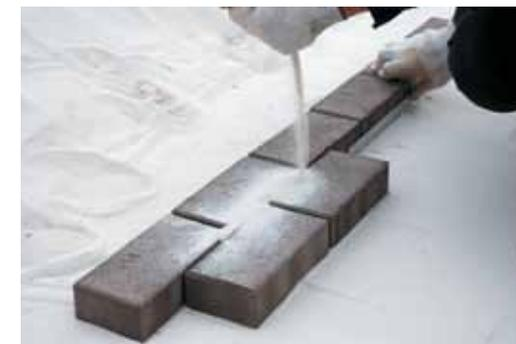
5. Швы заполняются сеянным песком, модуль крупности которого не должен превышать размеры шва.
