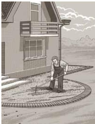
Подсыпка равномерно распределяется по поверхности несущего слоя и предварительно разравнивается с помощью подручного инструмента (например, граблей). Монтажный слой трамбуется (уплотняется) специальным электро- или бензоинструментом (виброплита).
