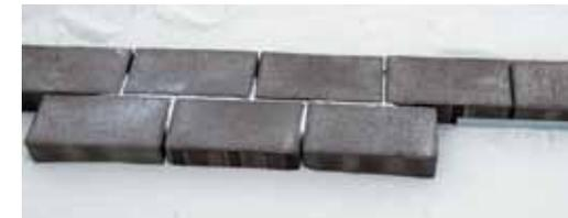
6. Обязательно качественное заполнение швов абсолютно сухим песком, либо послойное заполнение влажным песком с последующей проливкой за 2-3 раза. При эксплуатации участка в случае вымывания песка производится просыпка швов.
