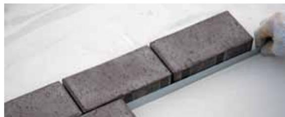
3. При несовпадении вертикальных и горизонтальных швов выполняется «разгонка» швов каждого ряда вручную.
