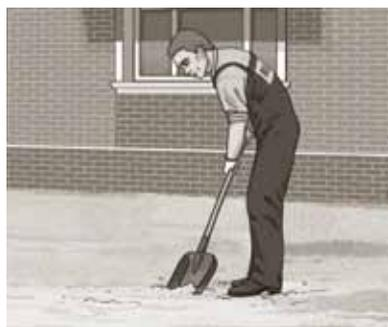
На уплотненный грунт отсыпается и разравнивается необходимое количество песка (ПГС, отсева).
