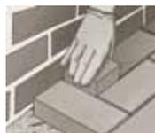
В местах примыкания мощения к границам площадки всегда остаются пустоты, меньше целого кирпича по размеру. Они заполняются доборными камнями, которые изготавливают при помощи отрезной пилы («болгарка») или циркулярная пила с диском для камня.
